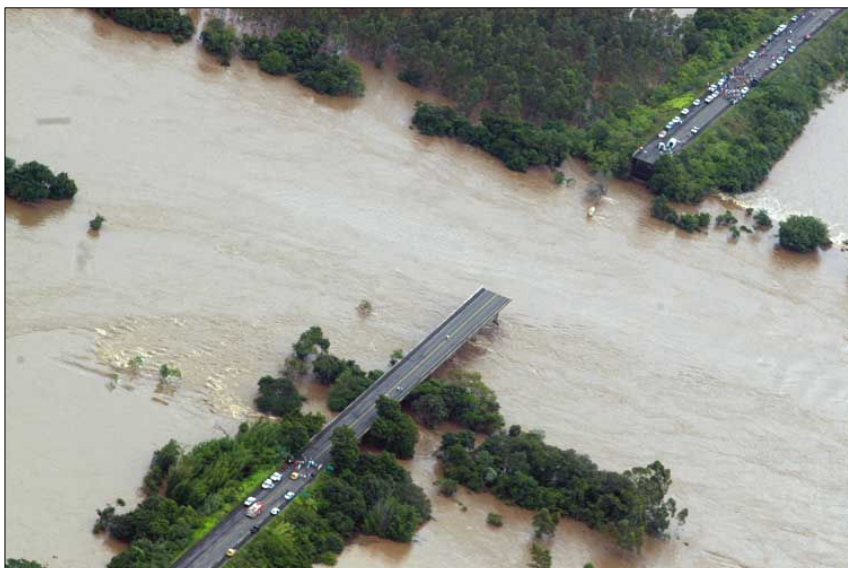
Figura 2: parte da ponte desabada sobre o rio Jacuí Foto: Zero Hora
