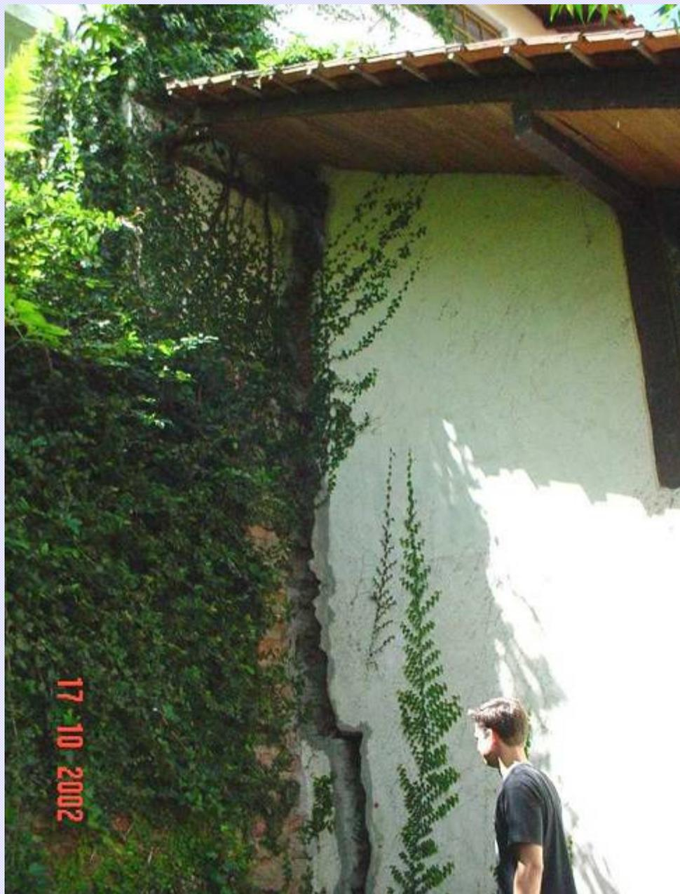
Resultados do monitoramento de deformações: superfície de ruptura bem definida no contato colúvio x rocha alterada.
